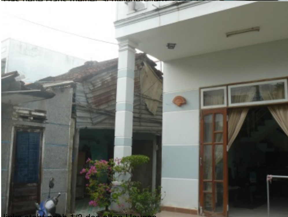
links steht noch 1/3 des alten Hauses
